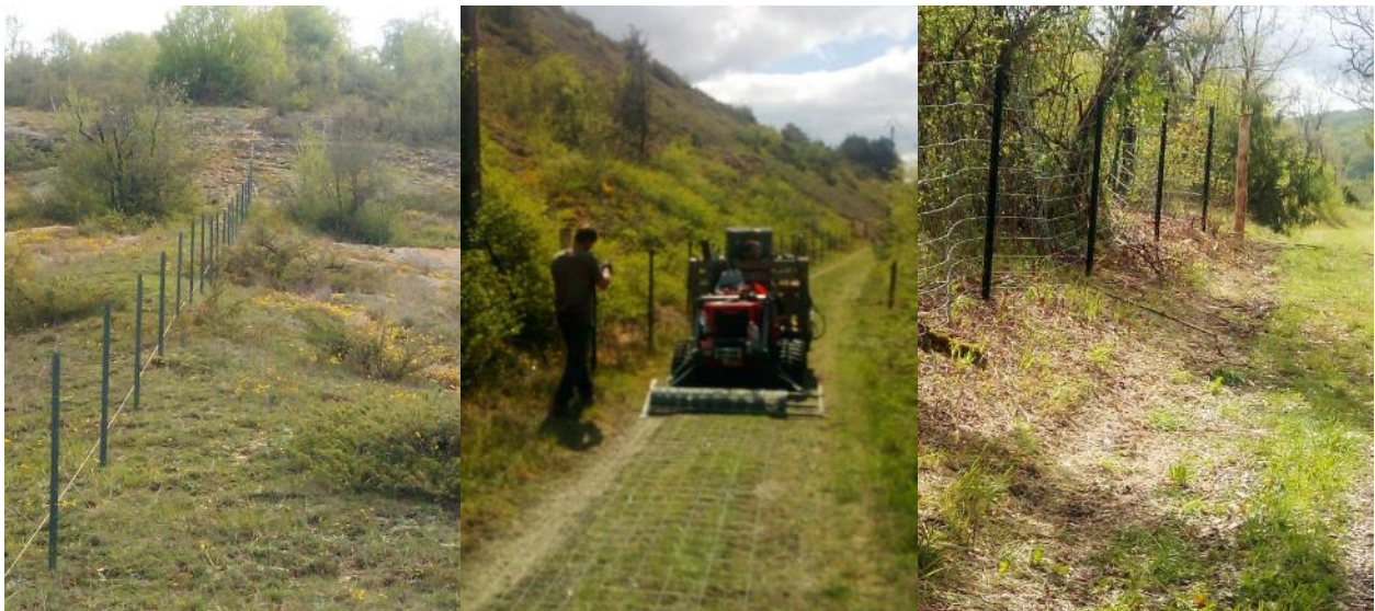
Figure 10 : Pose du fil de tension / Déroulage des rouleaux de grillage ursus / Pose du grillage ursus
