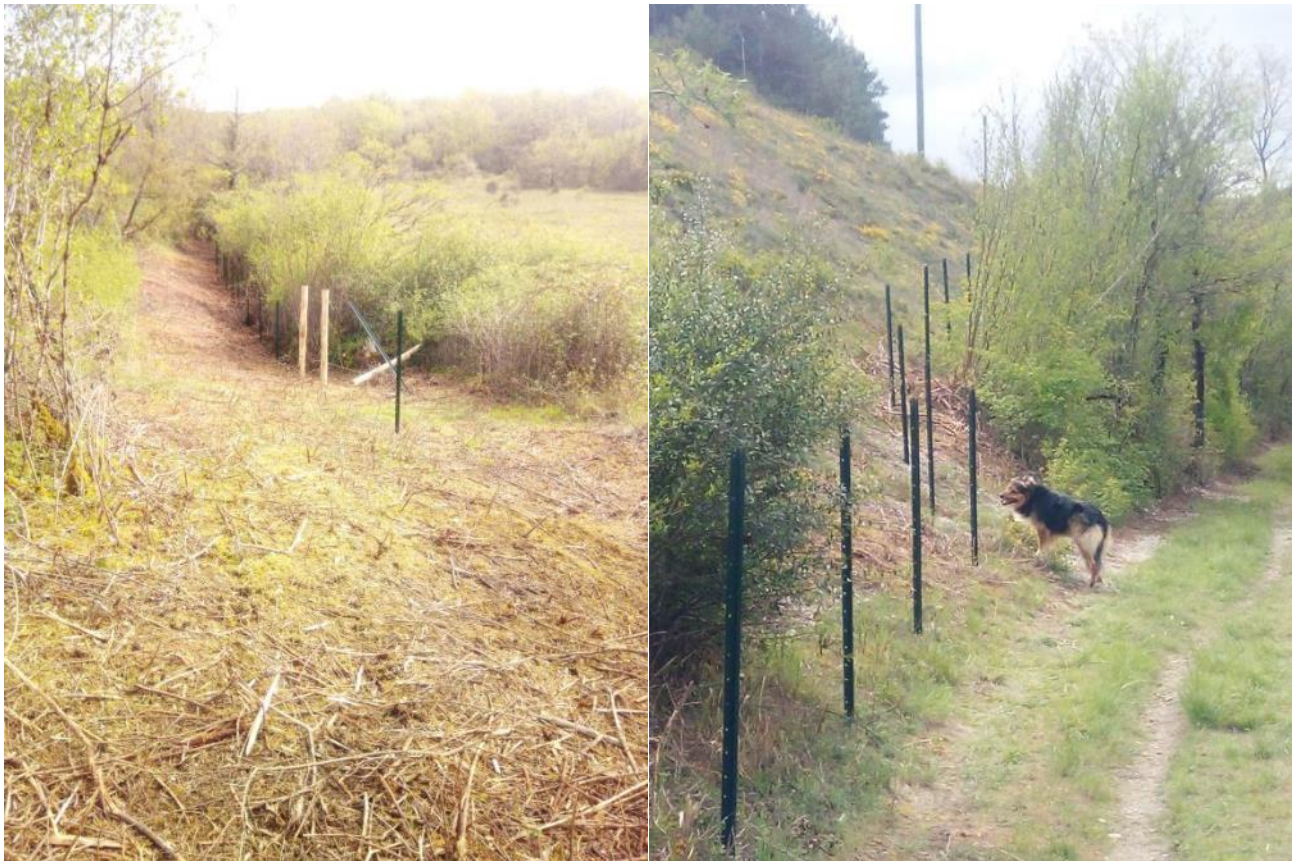
Figure 9 : Vue après la création des layons et début de mise en place des piquets fer
