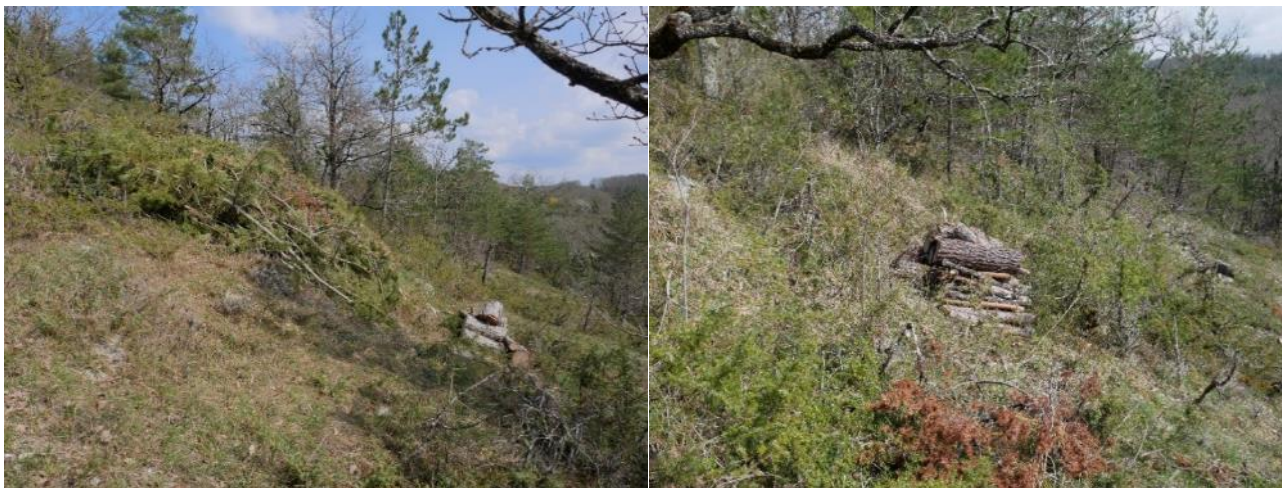
Figure 13: Entité 2 – A gauche : Bûcheronnage des pins / A droite : Stockage sur site des résidus de coupe
